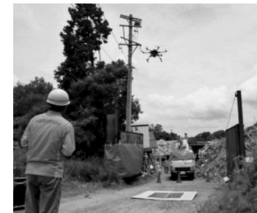
ドローンを用いた上空からの確認
