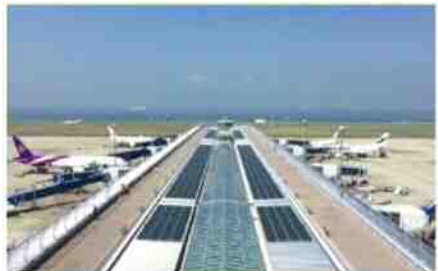
<太陽光パネル発電（第1ターミナルビル）>
