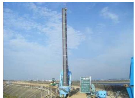
奥田海岸 鋼矢板工（西尾市）
