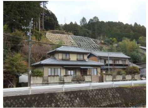
法枠工（岡崎市雨山町）
