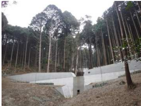
治山ダム〔谷止工〕（岡崎市夏山町）
