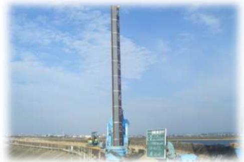
海岸堤防 奥田海岸を地震発生時の津波による被害から守るための耐震整備〔鋼矢板工〕
