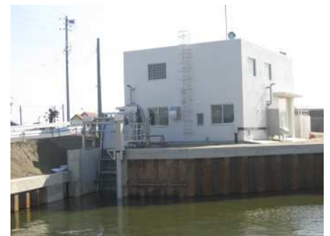
酒手島排水機場（西尾市）
