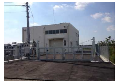
深池排水機場（西尾市）
