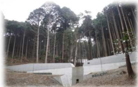
山地災害に対する防災機能向上を図る治山ダム〔谷止工〕
