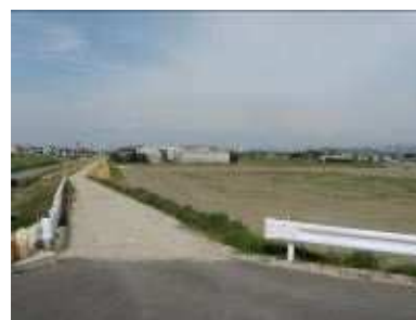
住環境整備事業深池地区（ほ場整備）
