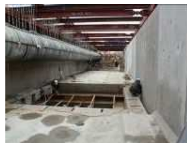
かんがい排水事業中井筋地区 （工事中 排水路）
