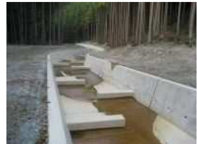
治山施設(流路工)
