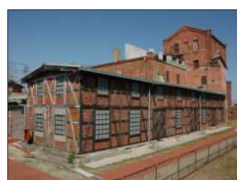
半田赤レンガ建物（半田市）
