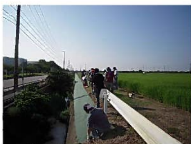
防草シートの設置
