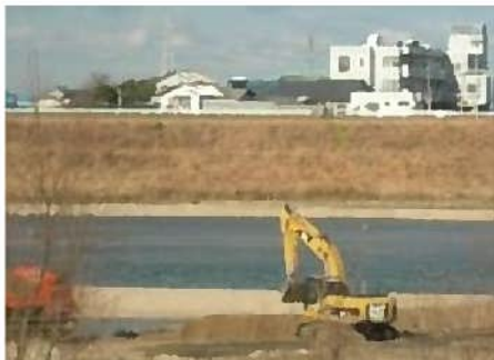
矢作川の河床浚渫
