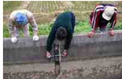
施設の機能診断
