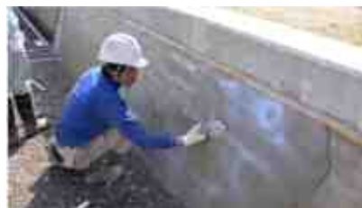
老朽化した水路壁のコーティング 未舗装の農道をアスファルトで舗装
