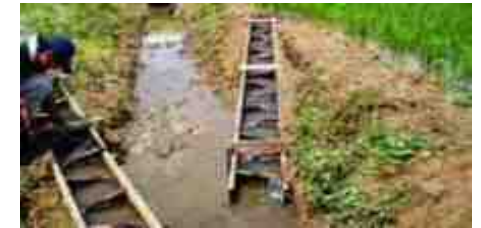
水田魚道の設置
