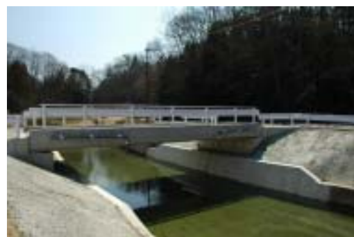
取付道路整備 海上の森入り口駐車場に入る道路を整備しました。
