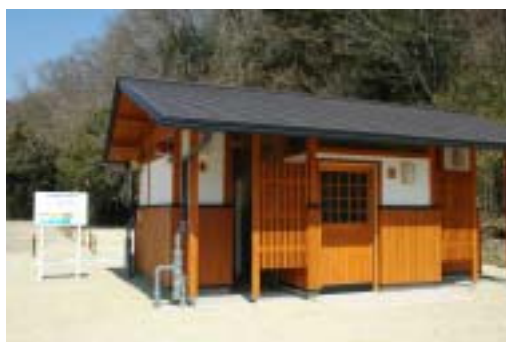
エコトイレ 海上の森入り口駐車場に設置
