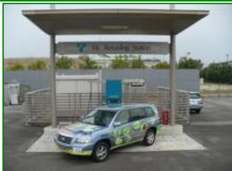
東邦ガス技研水素ステーション (東海市 ; H14/10~)
