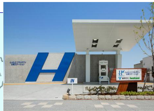
とよたエコフルタウン水素ステーション (豊田市 ; H25/5~)
