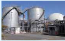
富山エコタウン 「富山グリーンフードリサイクル」
