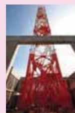
地上観測設備
