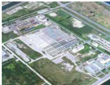
【 矢作川浄化センター(西尾市) 】
