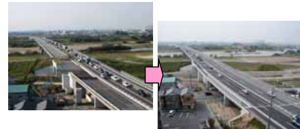
(主)岡崎刈谷線渡橋4車化(岡崎市)
