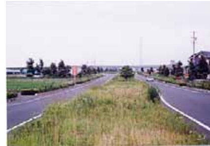
【 国道 259 号植田バイパス (豊橋市) 】
