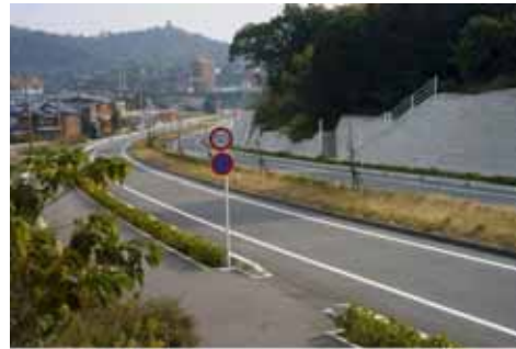
【 国道 247 号中央バイパス （蒲郡市） 】
