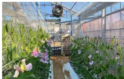
ヒートポンプによる冷房・除湿
