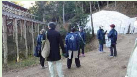
* 工事現場視察
