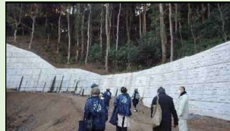
* 工事現場視察 *
