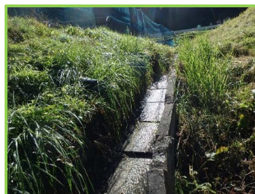
農地環境整備事業 大野瀬地区（整備前）
