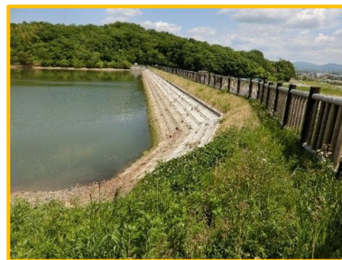
防災ダム事業 伊保新池・蓮池地区 (整備後)
