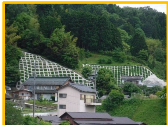
人家裏山腹に施工した法枠工
