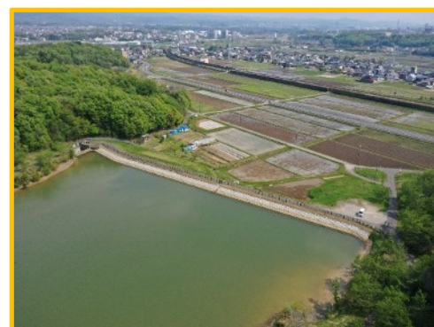
防災ダム事業 伊保新池・蓮池地区 (全景)
