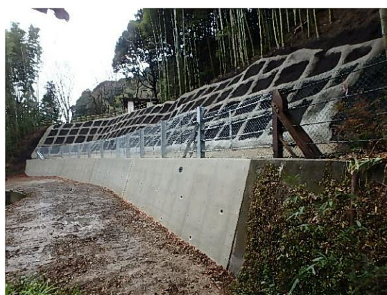
土留工（春日井市）
