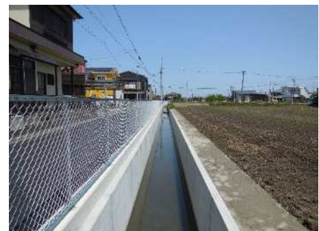
【排水路の改修】(津島市)
