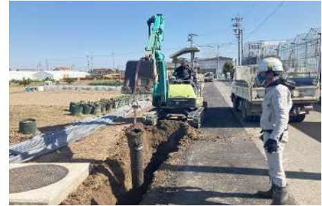
【石綿セメント管の撤去】(弥富市)
