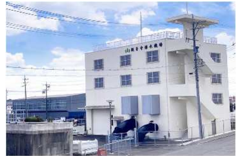
【排水機場の整備】（蟹江町）
