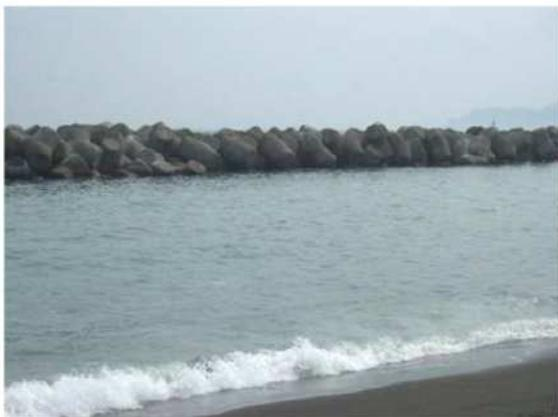
↑従来のコンクリートブロック工法による重力式の離岸堤による消波ブロックの立ち上がりの例。消波ブロックにより水平線への眺望が阻害される。
