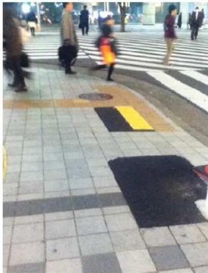
↑歩道全面にタイルを貼ると将来補修工事したとき「傷跡」が残る↑
