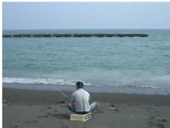
↑新型離岸堤（※）を採用した例。従来の重力式離岸堤に比べ海面からの立ち上がりが少なく、水平線への眺望が確保される。
