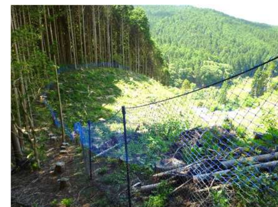
獣害防止柵設置（豊田市阿蔵町保戸嶋 地内）
