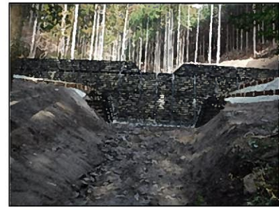
治山ダム(鋼製自在枠)近景
