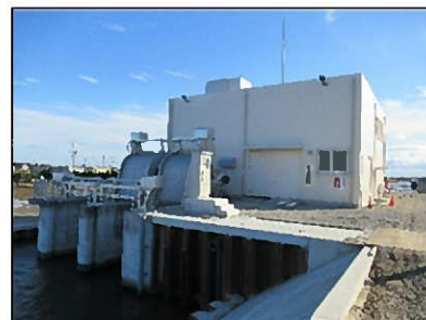
大岡排水機場(全景)
