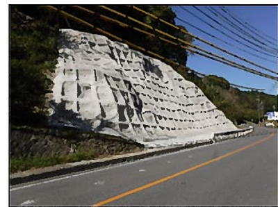
法枠工(簡易法枠)近景
