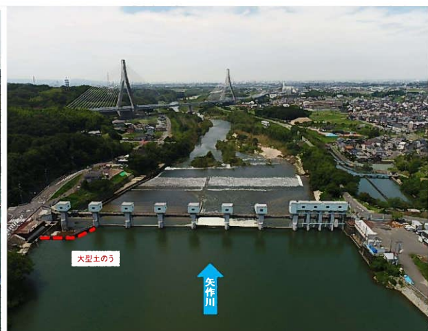
令和5年7月3日 大型土のう等設置による自然取水
