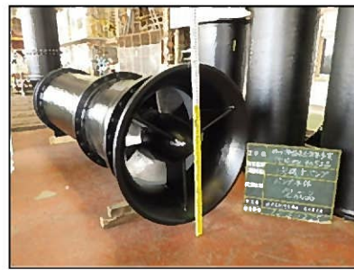
分解整備したポンプ
