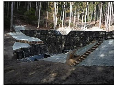
治山ダム(鋼製自在枠)遠景
