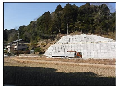
法枠工(簡易法枠)遠景
