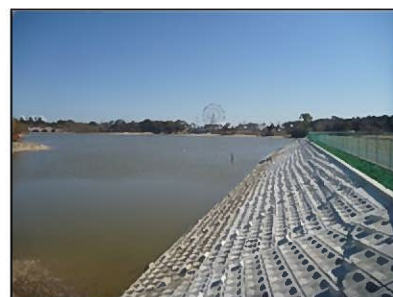
補強された堤体
