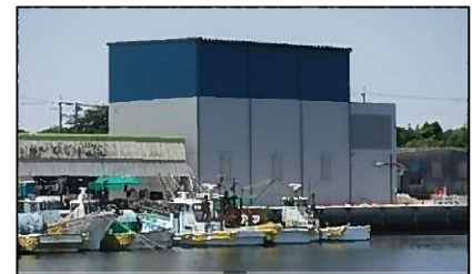
完成した製氷貯氷施設
