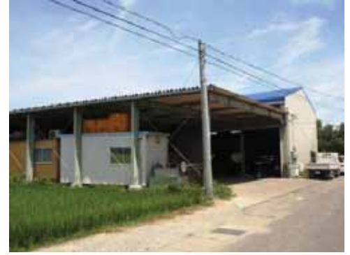
東川トラクターの倉庫
