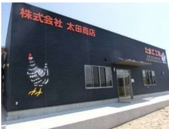
GPセンターの外観
