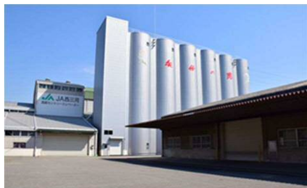
西部カントリーエレベーター
