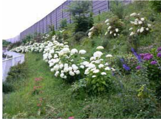
藤澤常務が管理する国道沿いの法面
