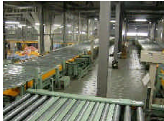
場内の搬送用コンベア（中2階）
