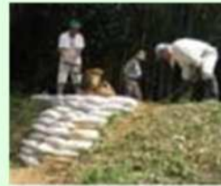
漏水箇所の補修
