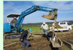
コンクリート水路の更新
