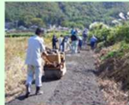
未舗装農道の舗装
