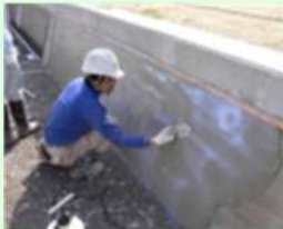
摩耗した水路壁への表面被覆材の塗布
