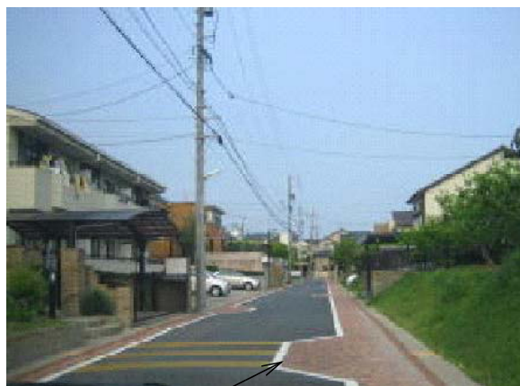
<視覚的シケインによる速度抑制対策>
