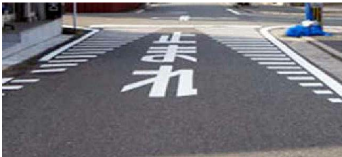
<「止まれ」に加え、減速ドットマークを設置>
