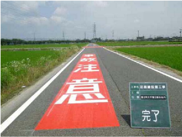
<交差点の手前に注意喚起路面標示を設置> <「止まれ」文字の周囲をカラー舗装>
