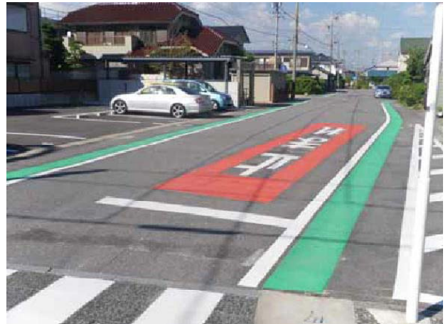
<交差点の手前に注意喚起路面標示を設置> <「止まれ」文字の周囲をカラー舗装>
