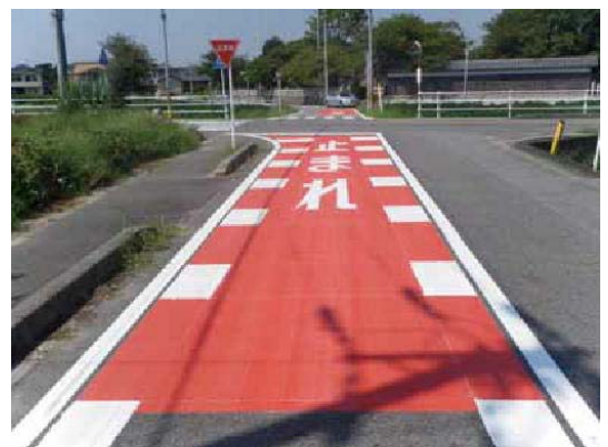
<「止まれ」に加え、注意喚起 カラー舗装と減速ドットマーク を設置>
