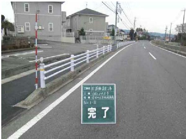
<車両用防護柵の設置>
