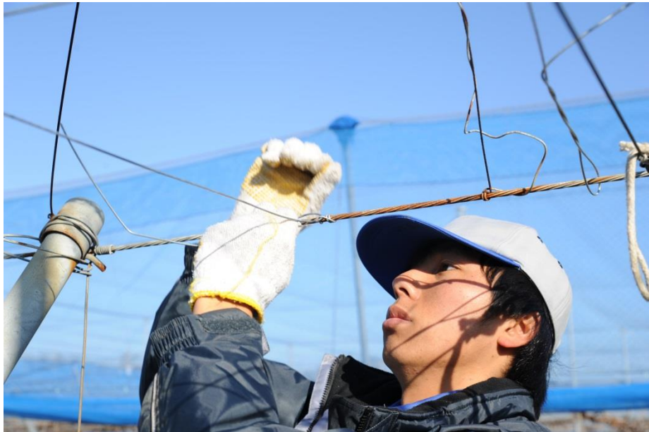
張線器を使って、もう一方の端にテンションをかけます
