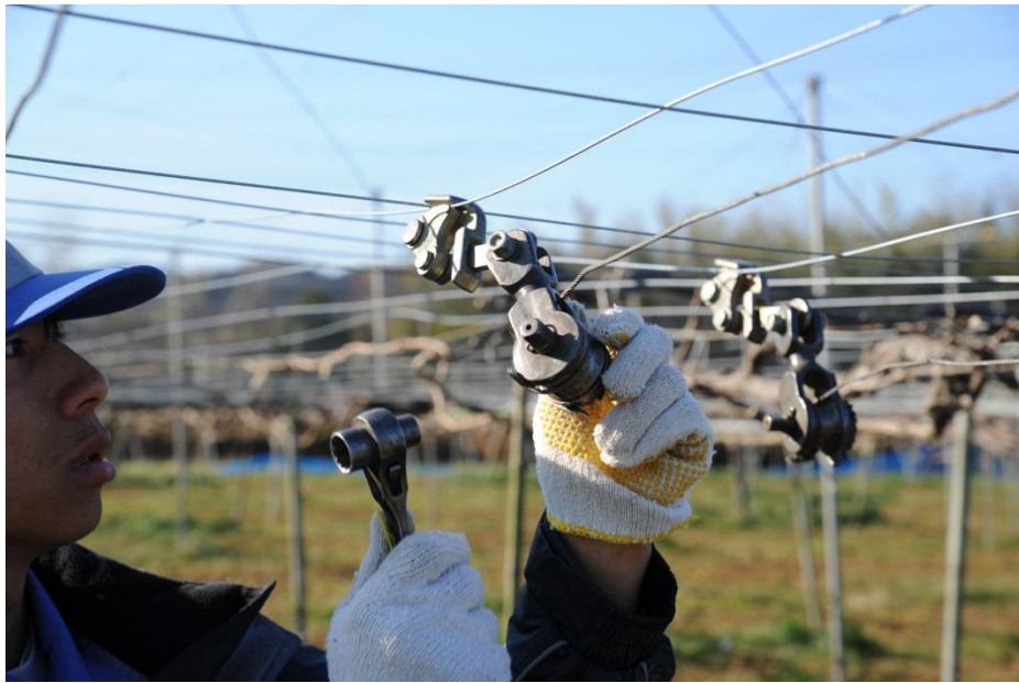
張線器を使って、もう一方の端にテンションをかけます
