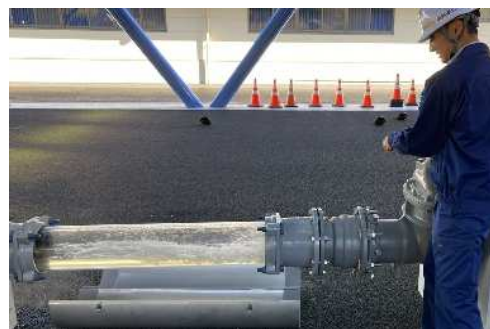
【透明管による充水状況の確認】
