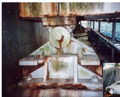
写真 6.1.1 ピンローラー支承の腐食
