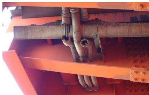
写真 6.2.5 排水桶の脱落（添架物も損傷）
