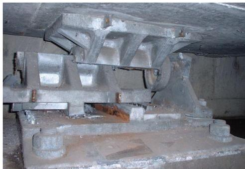
写真 6.1.3 ピン支承の地震による破損
