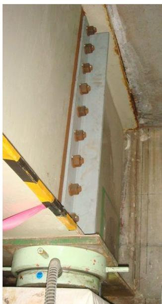
写真 6.1.6 ジャッキアップ補剛材の設置例
