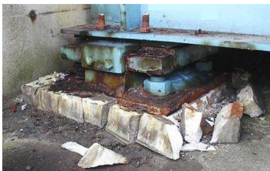
写真 6.1.4 沓座モルタルの破損
