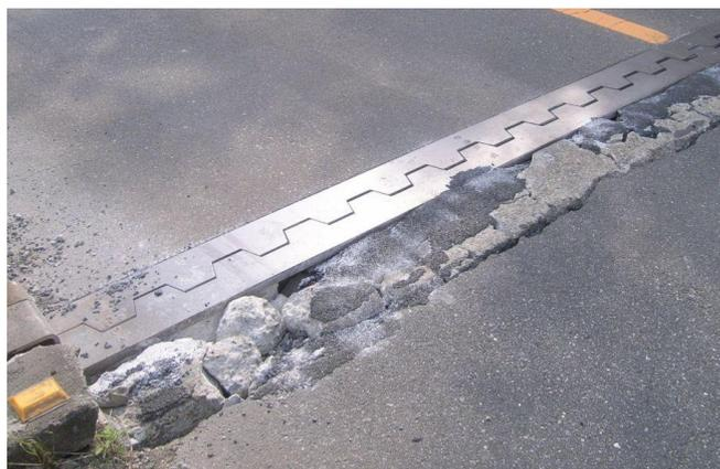
写真 6.2.3 後打ちコンクリートの損傷
