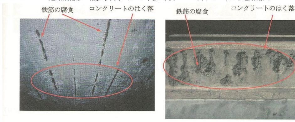
写真 5.2.1 中性化による変状事例
