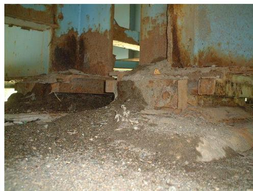
写真 6.1.2 支承板支承の土砂堆積に伴う腐食
