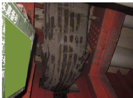
写真 6.2.4 止水材の脱落
