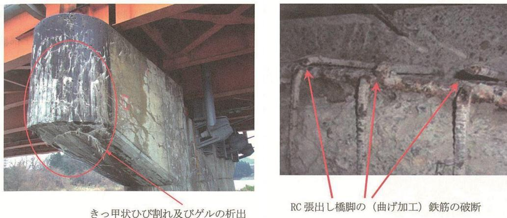
写真 5.2.4 アルカリ骨材反応による変状事例
