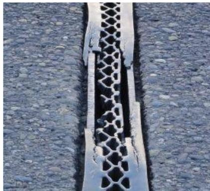
写真 6.2.2 ゴムの摩耗損傷
