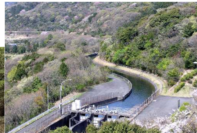
農業水利施設(農業用水路)
