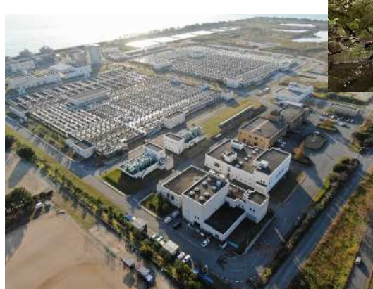
上工下水道施設(下水処理場)
