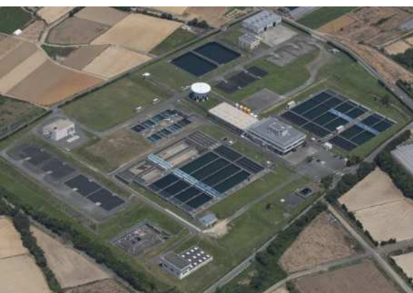
上工下水道施設(浄水場)
