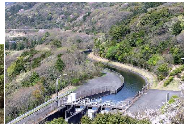
農業水利施設(農業用水路)
