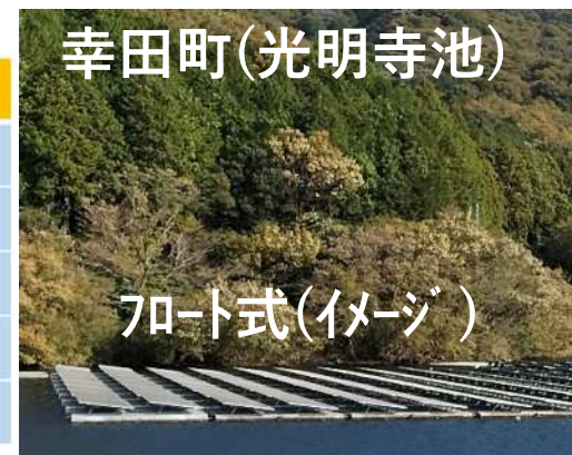
フロート方式 洪水時には水位に追従してパネルが昇降
