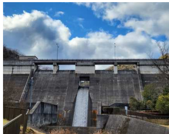
河川施設(ダム)
