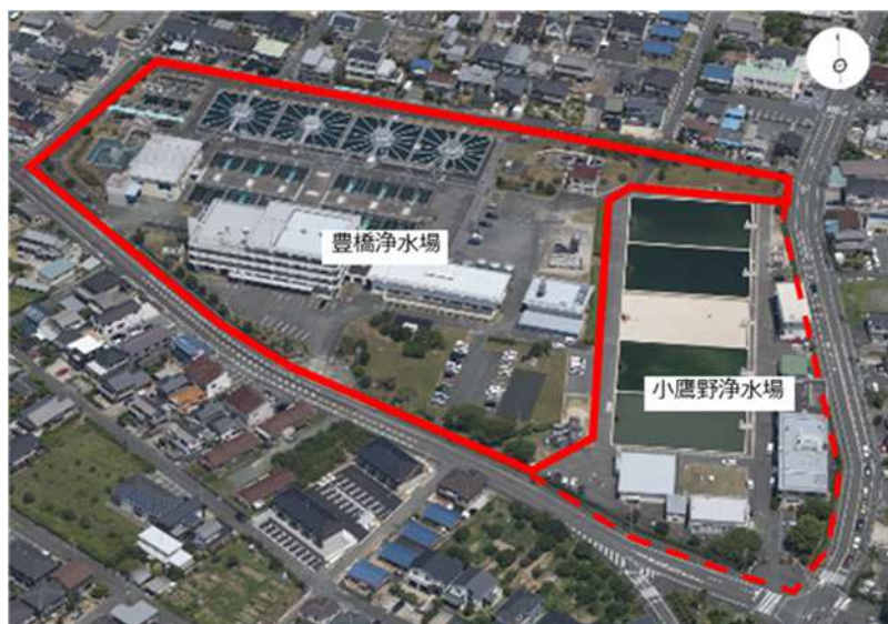
図表1 豊橋浄水場全景
