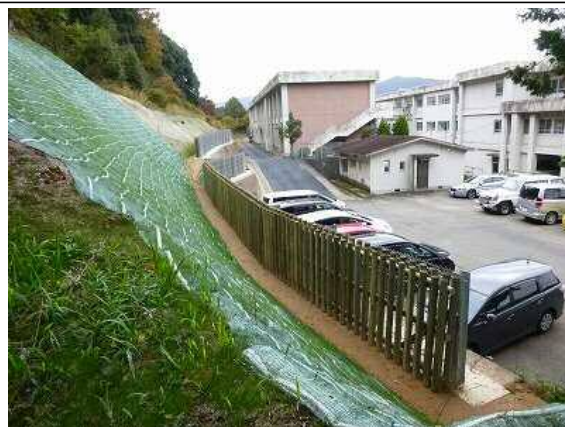
平成26年度山腹工施工地 (H26.11.28 新城市)
