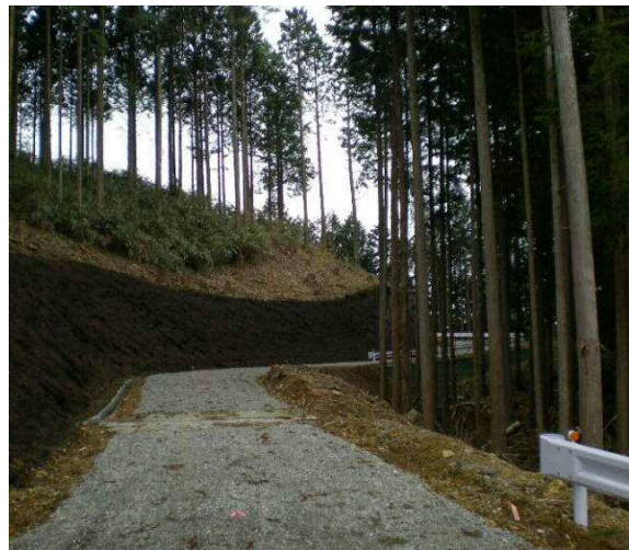
望月峠線の完了状況
