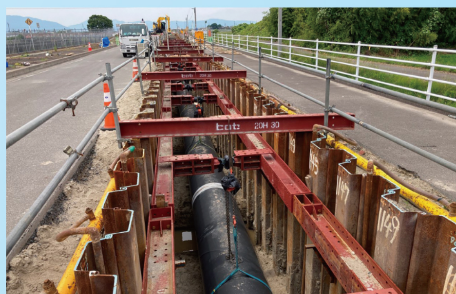
管路更新工事
