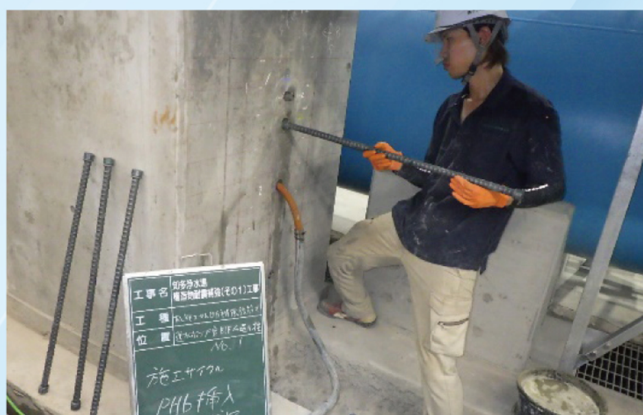
浄水池耐震補強工事
