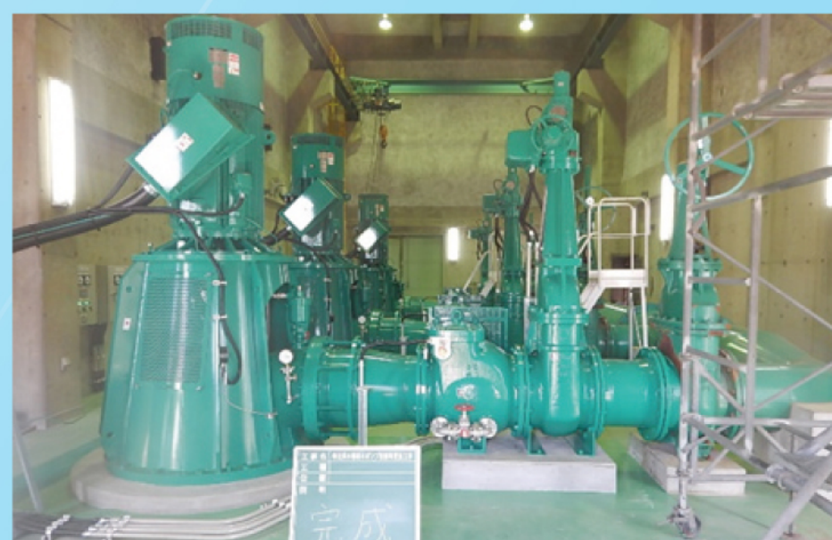
設備更新工事
