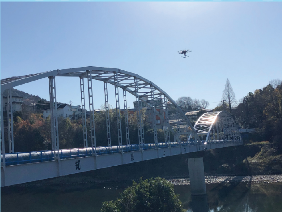
ドローンによる水管橋点検
