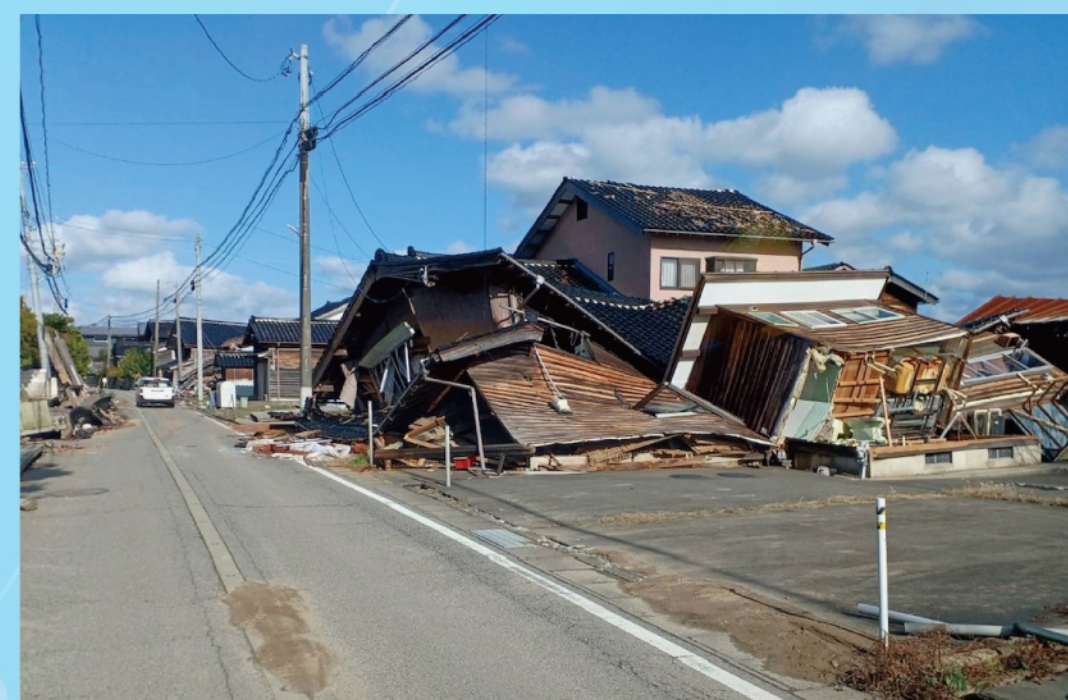
沿道家屋損壊状況
