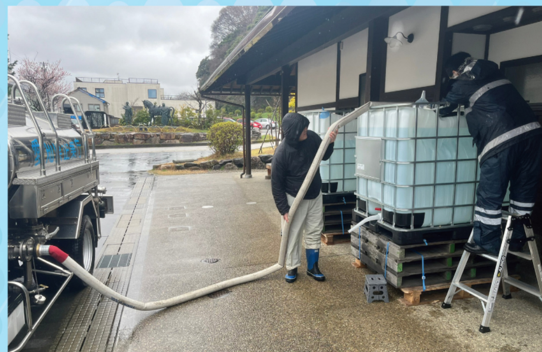
応急給水状況(給水車→タンク)
