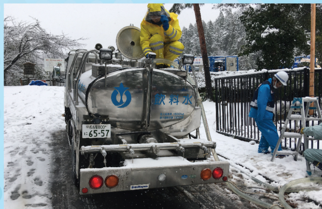
補水状況(水道管→給水車)
