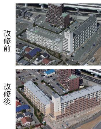
県営住宅の長寿命化改善工事
