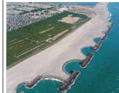
離岸堤（浜松五島海岸）
