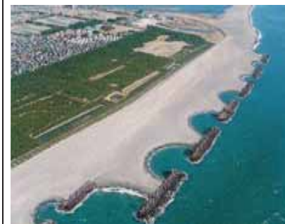
離岸堤（浜松五島海岸）
