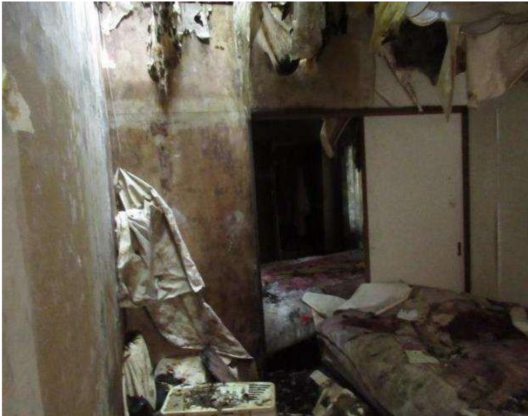
写真⑪ (内部 洋室 1)
