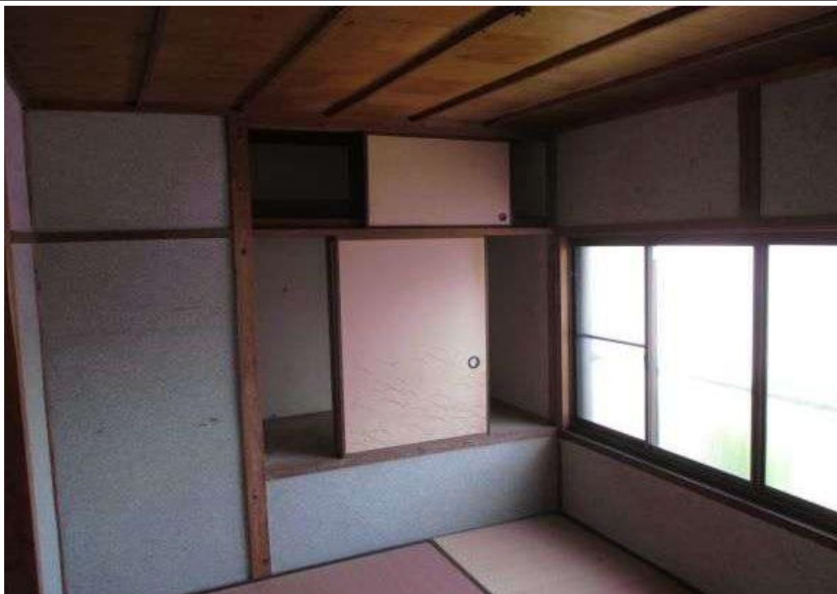
写真⑮（内部 和室 2）
