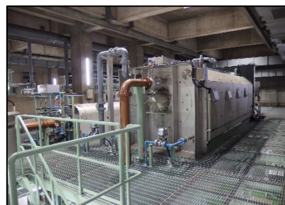
処理場 増設工事(汚泥処理施設)
