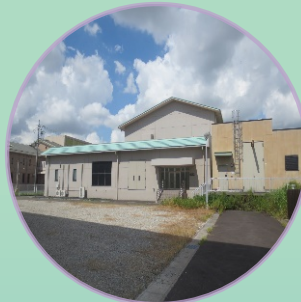
新川東部浄化センター
