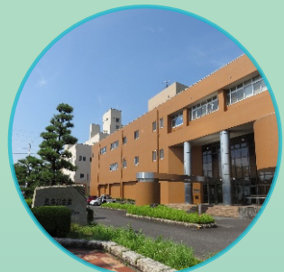
五条川左岸浄化センター
