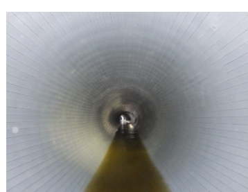
管きょ修繕完了
