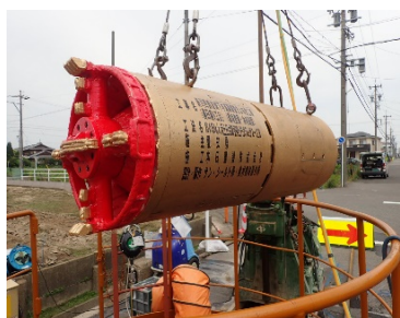
管きょ工事(掘進機)
