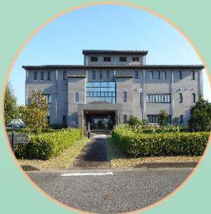
五条川右岸浄化センター
