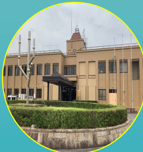
矢作川浄化センター
