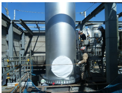
処理場 更新工事(焼却炉施設)
