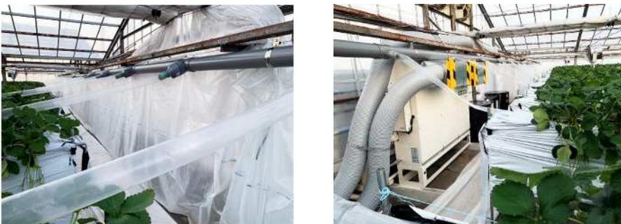
図6. ヒートポンプからの配管の様子
