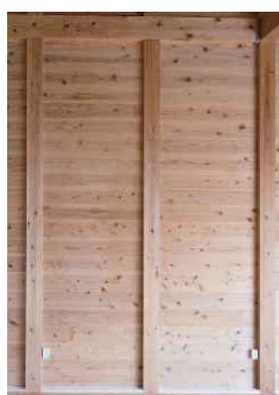
(a) 内側落とし込み板現し
