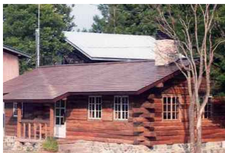
写真 3-5 丸太組構法 外部両面丸太現し（外部）
