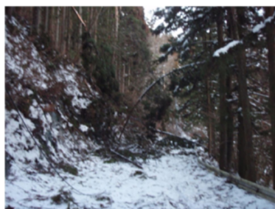
県道古真立津具線（設楽町津具地内）
