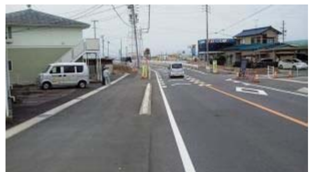
⑧仮設橋梁付近
