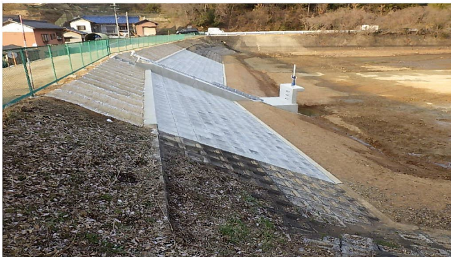
耐震対策を実施した虎熊大池（犬山市）
