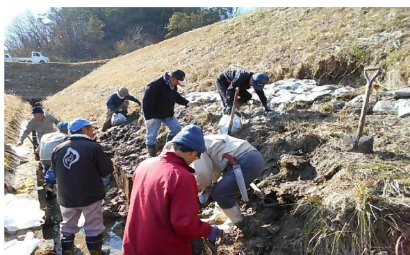
農地法面の補修(水土里の上半田川)
