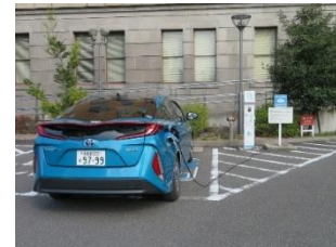
EV、PHV用充電インフラ
