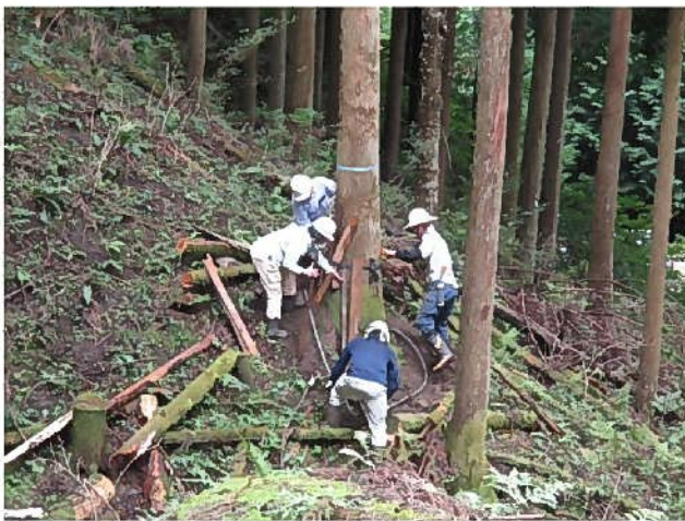
ガイライン設置状況
