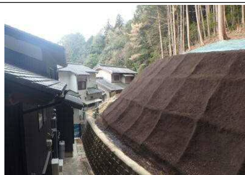
平成 28 年度吹付工施工地 (H29.2.20 新城市長篠)
